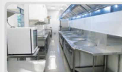
Bếp Nhà máy - Xí nghiệp Factory kitchen
